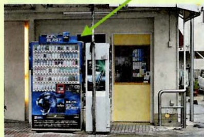
▲正面からの店舗全景
